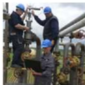
ISPITIVANJE VENTILA SIGURNOSTI BEZ DEMONTAŽE
